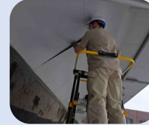
안전조치 후 작업 실시
