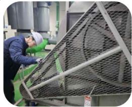
배기팬 협착 점검
